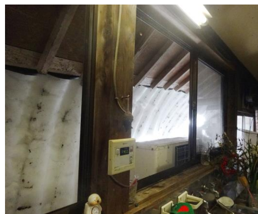
●2/11 大安禅寺の庫裡 屋根雪が、下まで続いている。
