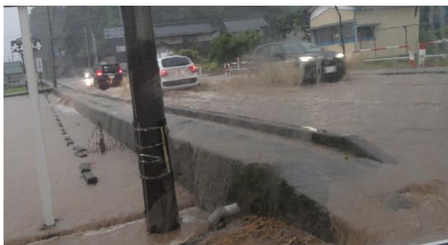
●7/29 午前6時32分 大安寺幼稚園前 田の谷川の越水
