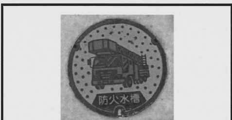
公園や空地に設置される防火水槽
